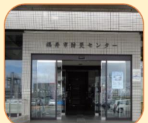
防災センター
